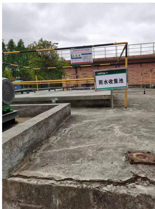
初期雨水收集池
