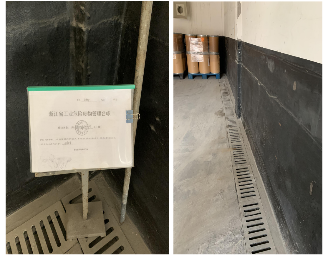
危废堆场内部照片
